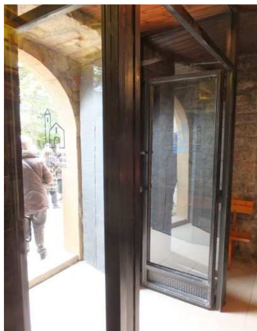
Exemple de vestíbul tancat visitable. Santuari de la Salut de Viladordis.
